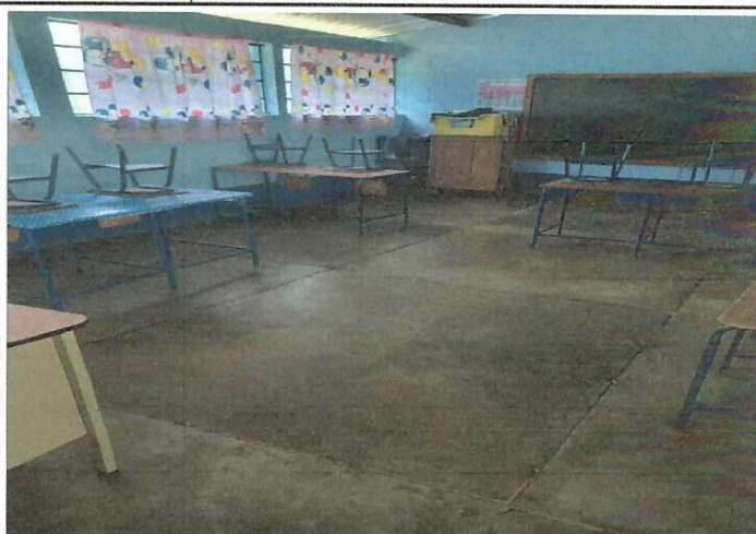
Foto 2: Mejoramiento de Instalación de piso (duela).
