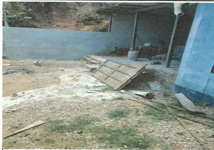
Foto 1: Mejoramiento de muro en área de cocina.
